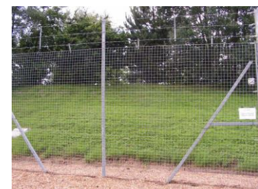
Imagen 2: Vallas de protección
